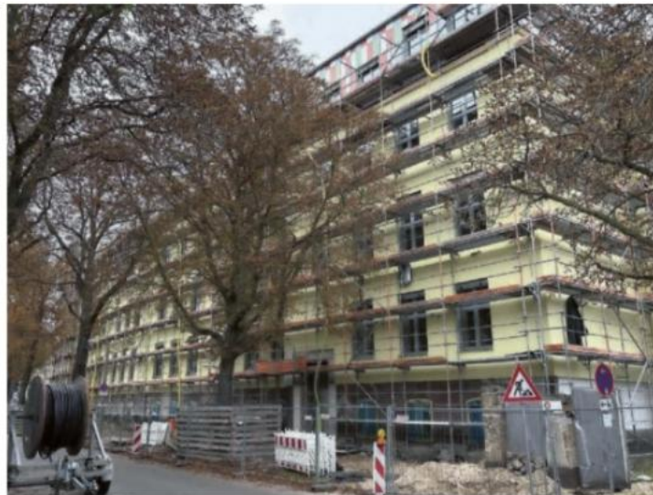
Die Hasengrund-Schule in der Charlottenstraße in Pankow. Seit fünf Jahren wird hier gebaut. Foto: Laura Wagener
